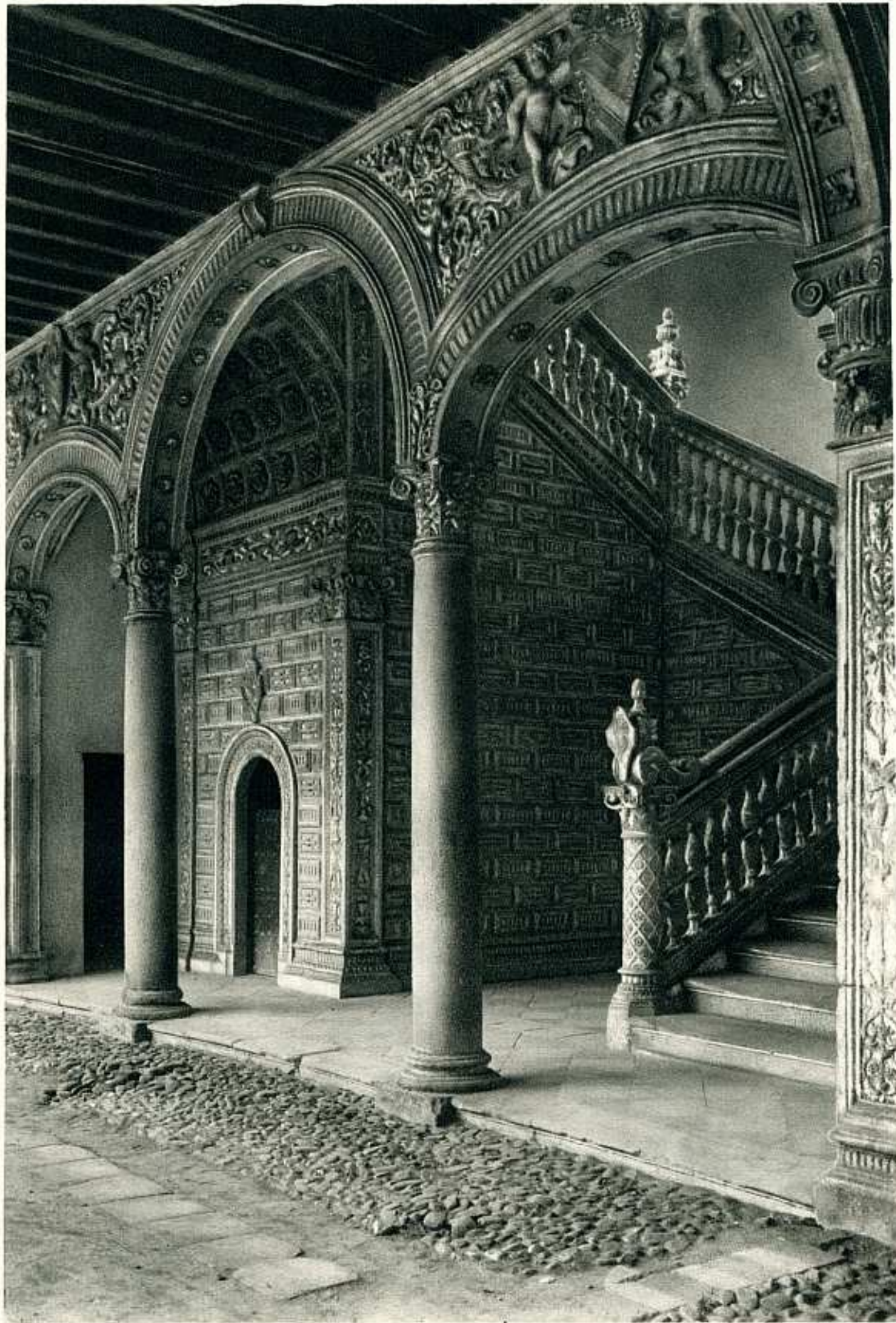
HOSPITAL DE SANTA CRUZ. ESCALERA
