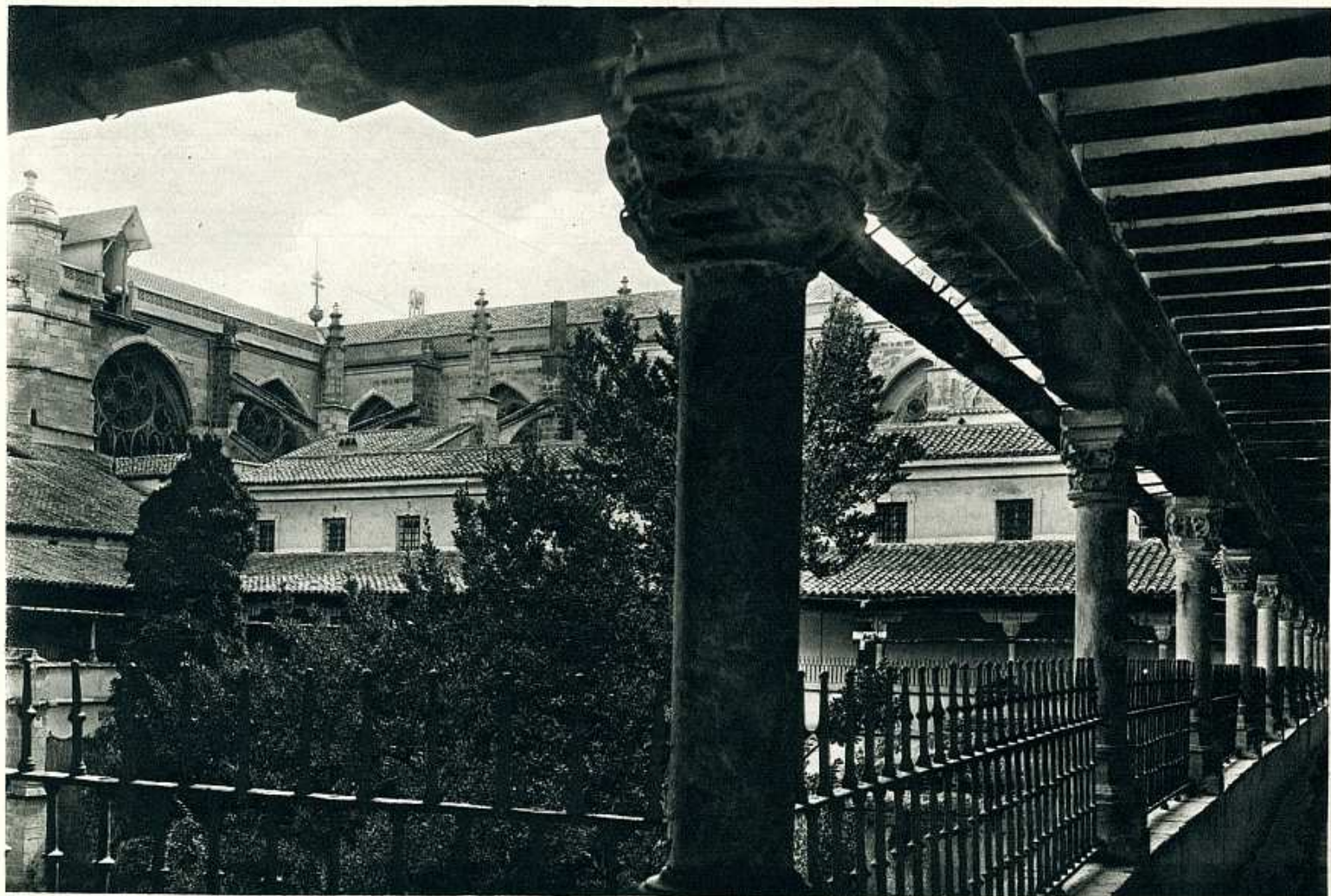
LA CATEDRAL. GALERÍAS ALTAS DEL CLAUSTRO
