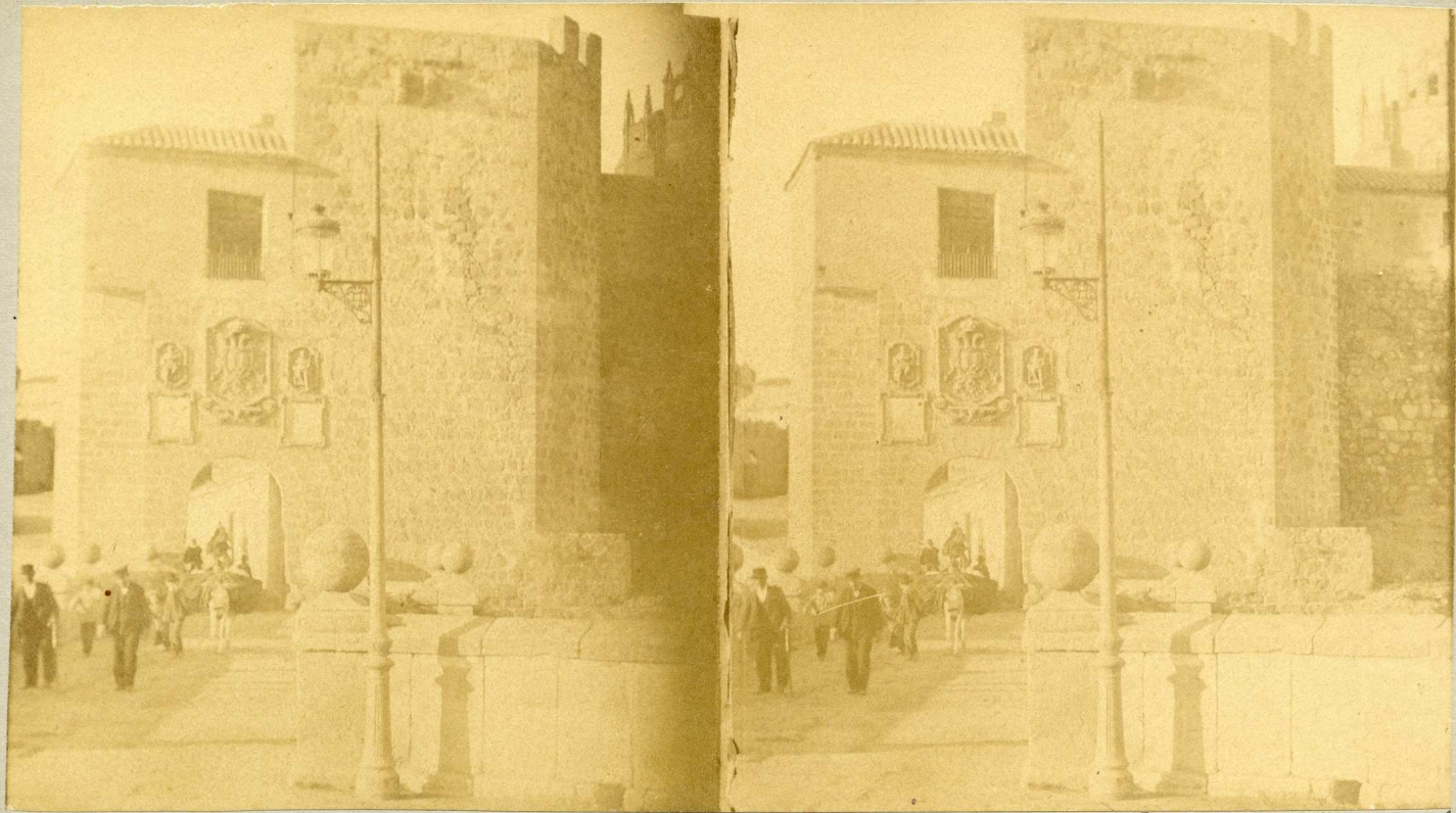
X Toledo. Interior del Puente de S. Martin
