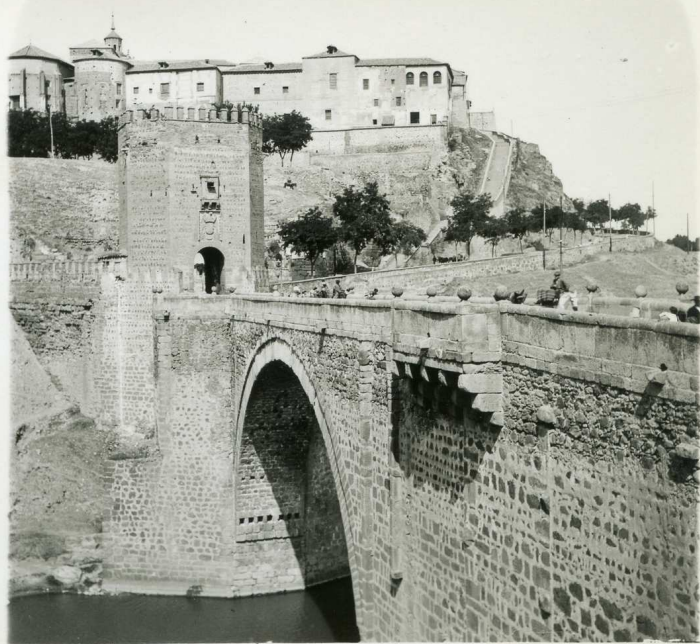
S. 191 - 5220. Tolède. Pont d'Alcantara.
