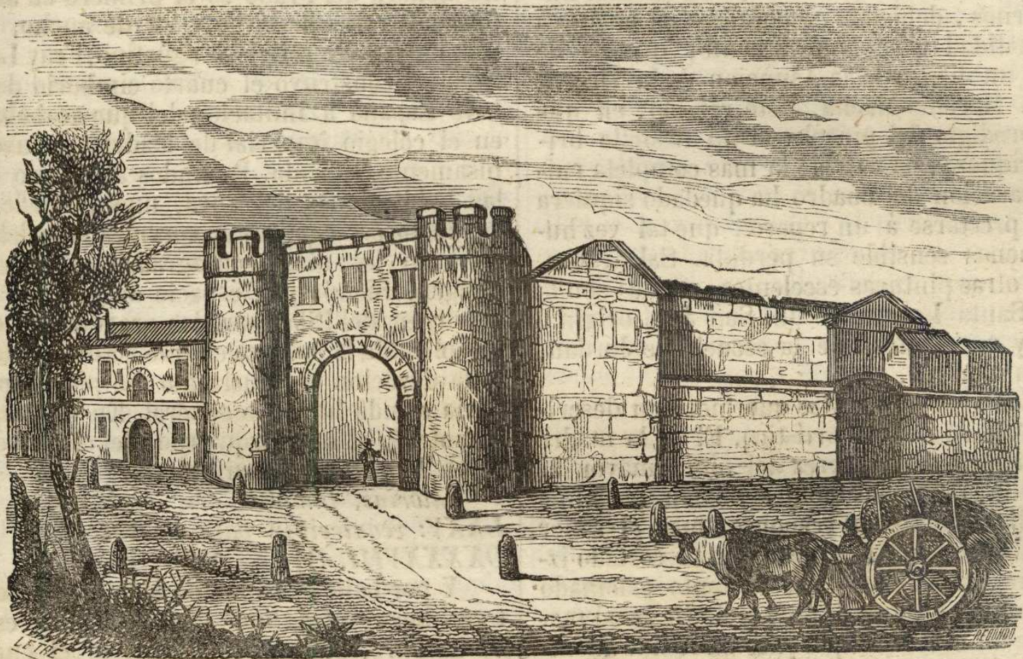
Puerta de Cuartos y ruinas de la casa del P. Mariana.
