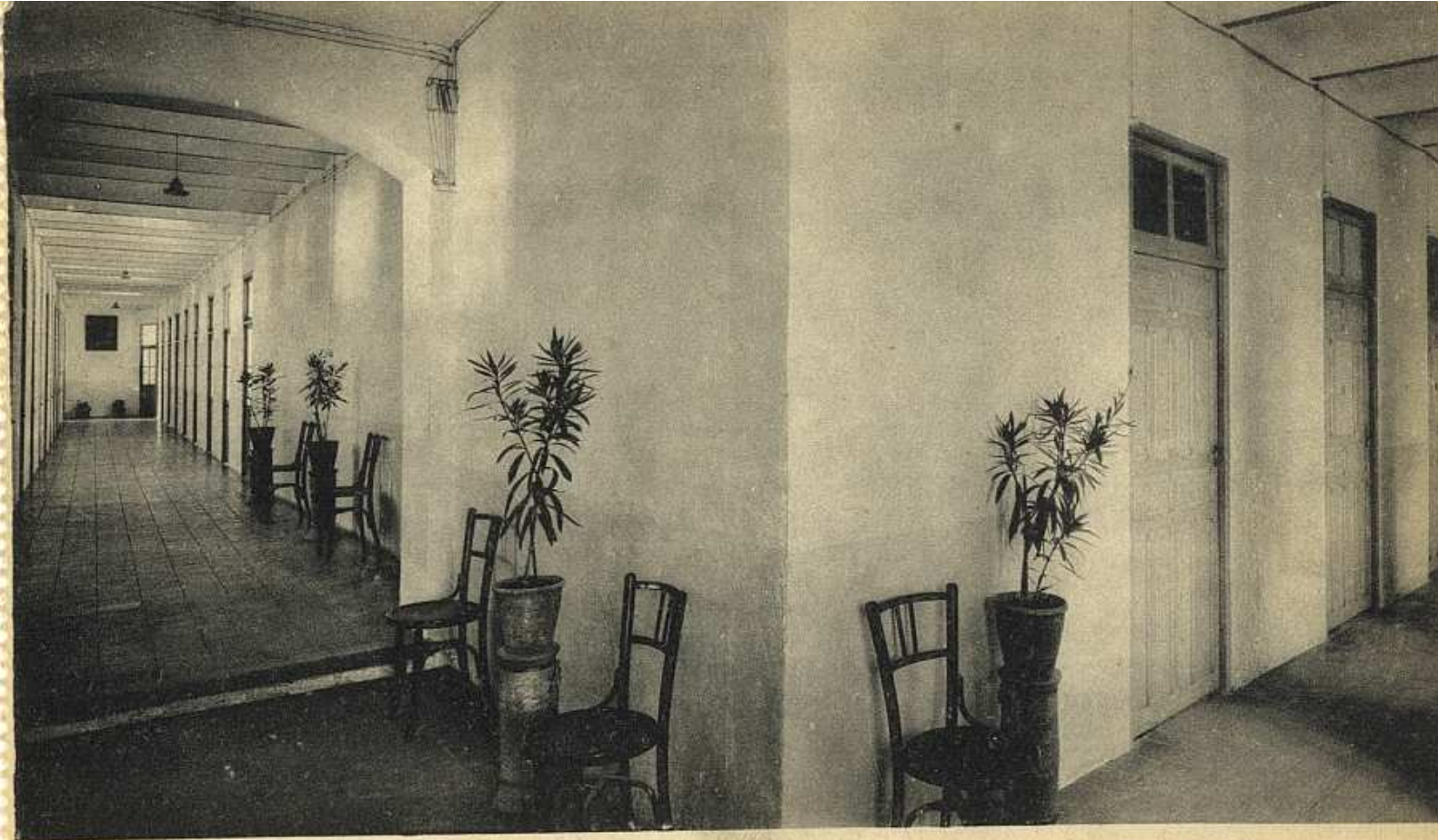
3 - TOLEDO. Academia de Hermanos Maristas. Galerías 2. piso. Sección Bachillerato
