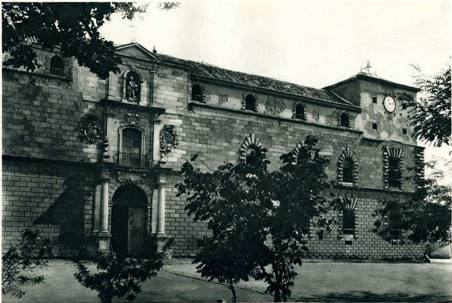
HOSPITAL DE AFUERA. FACHADA PRINCIPAL
