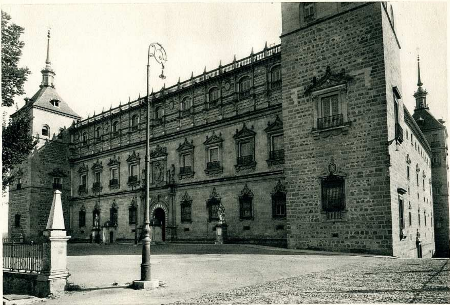
FACHADA PRINCIPAL DEL ALCÁZAR
