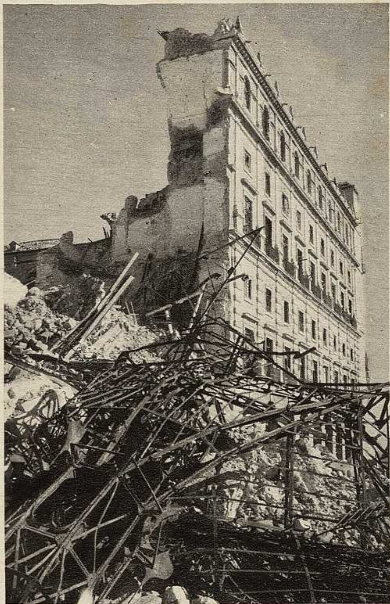
Núm. 14. Fachada Sur o de Capuchinos, obra de Herrera, con la osamenta de un torreón.
