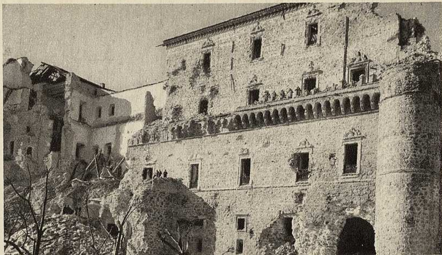
Núm. 13. Derrumbe de la fachada Este en la esplanada de los desfiles.
