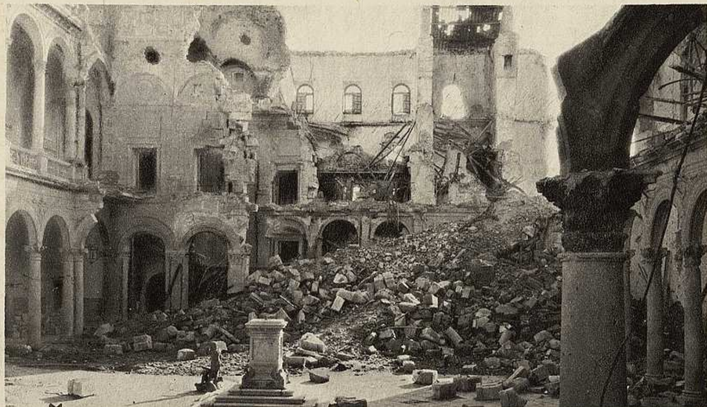
Núm. 6. ... es ahora montón de bloques de piedra y resto de galerías y columnatas.
