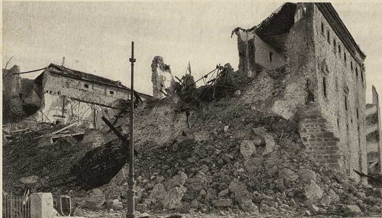
Núm. 4. ... fué destruída por la artillería roja durante el asedio.
