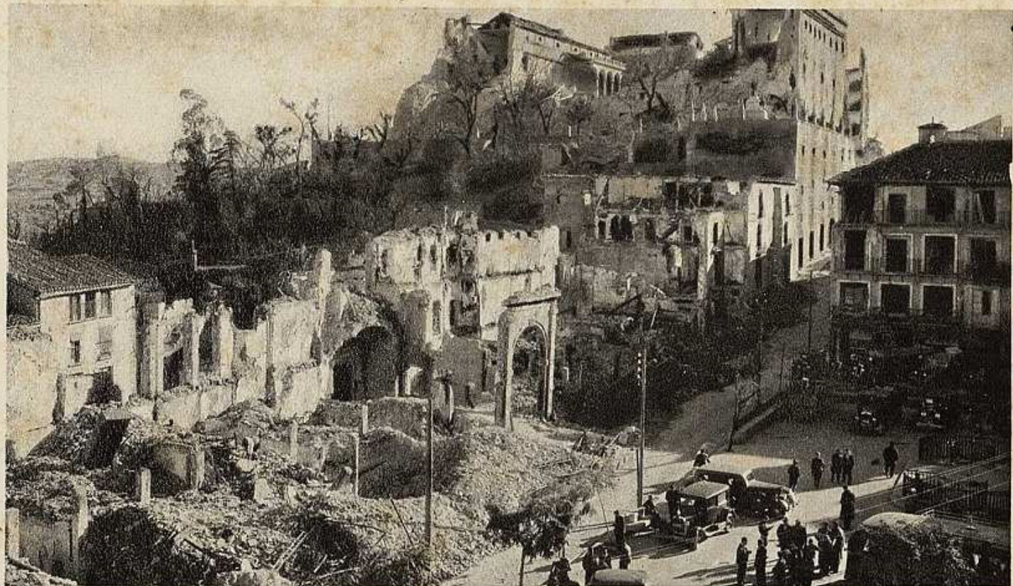
Núm. 2. El marxismo lo ha reducido todo a escombros.
