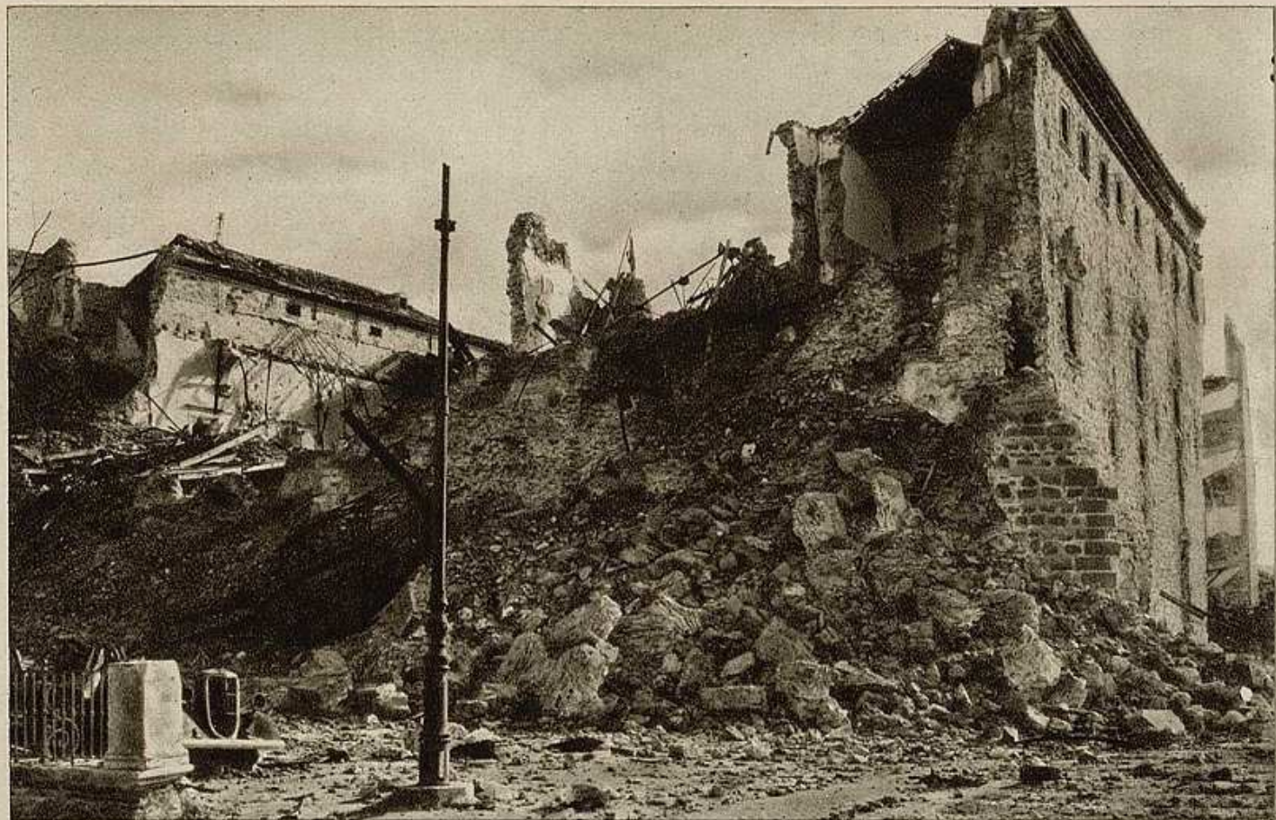
TOLEDO.—Alcázar. Fachada principal, después del asedio.
