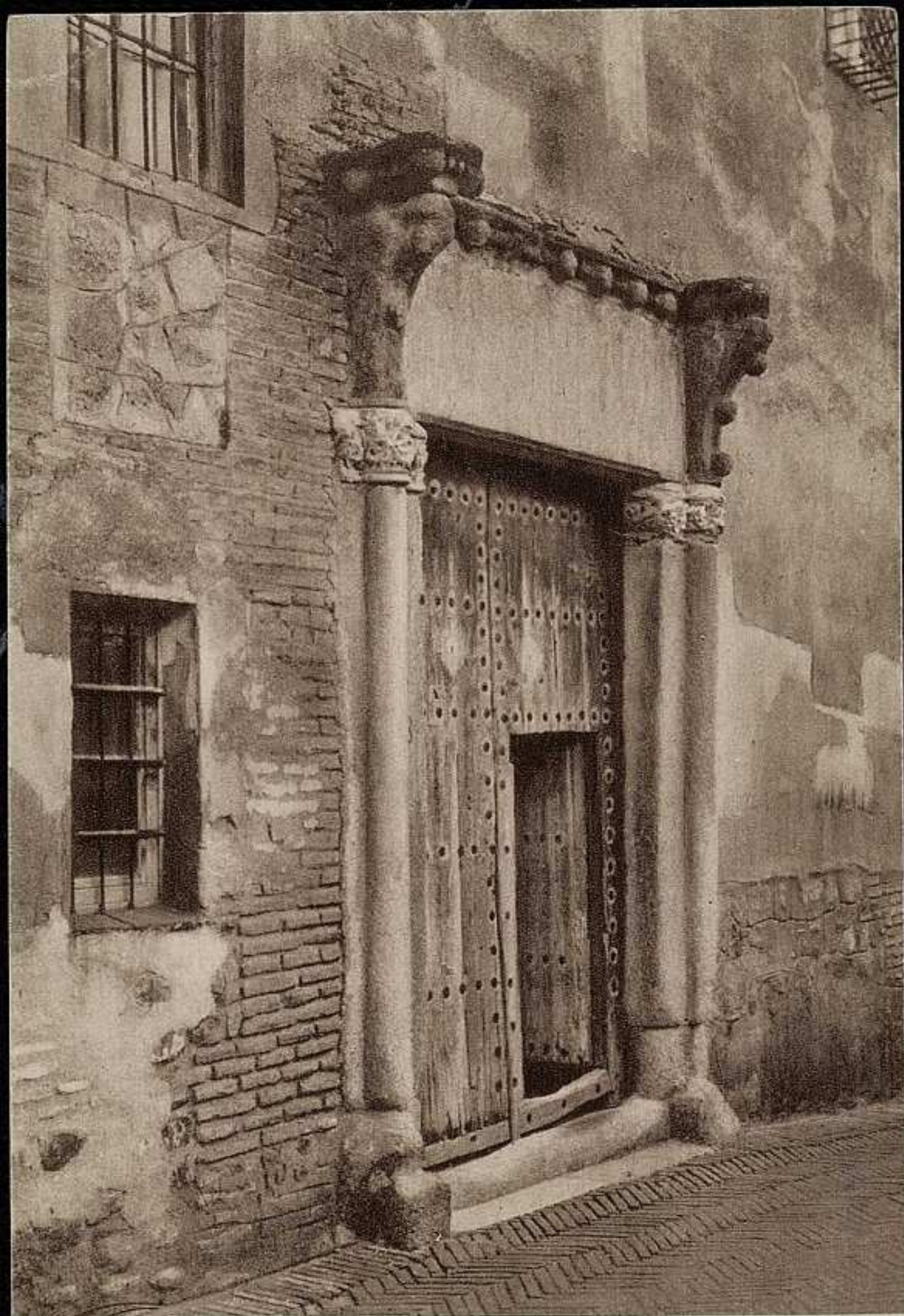
Casa del Greco. - Puerta de entrada.
