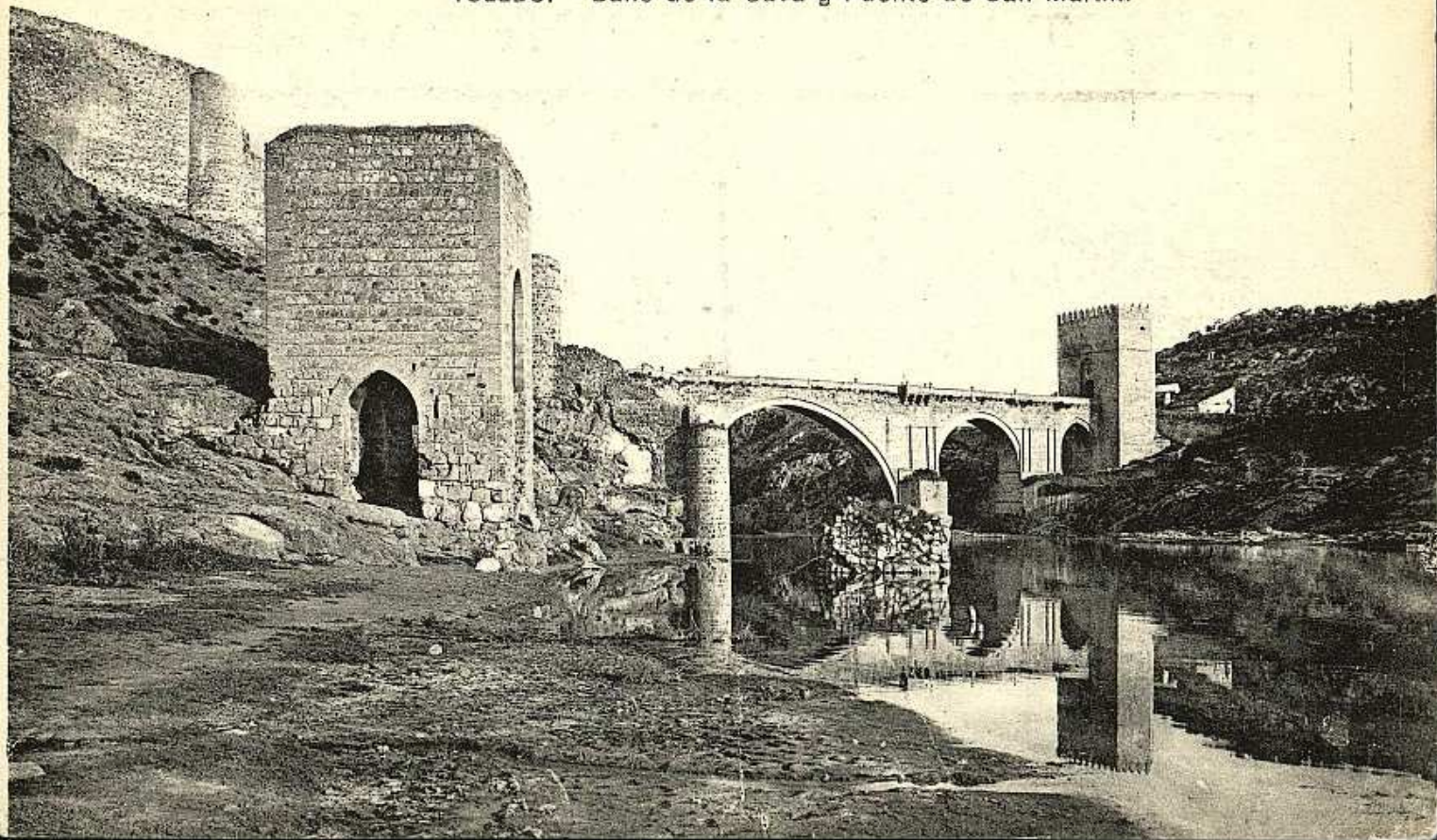
TOLEDO. — Baño de la Cava y Puente de San Martín.
