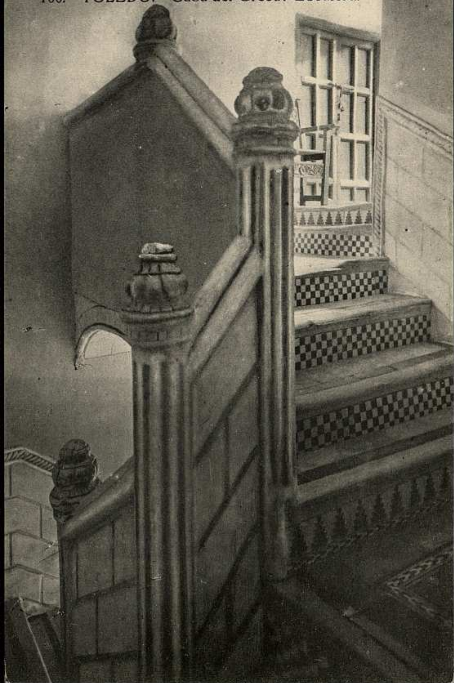
100. TOLEDO. - Casa del Greco: Escalera.
