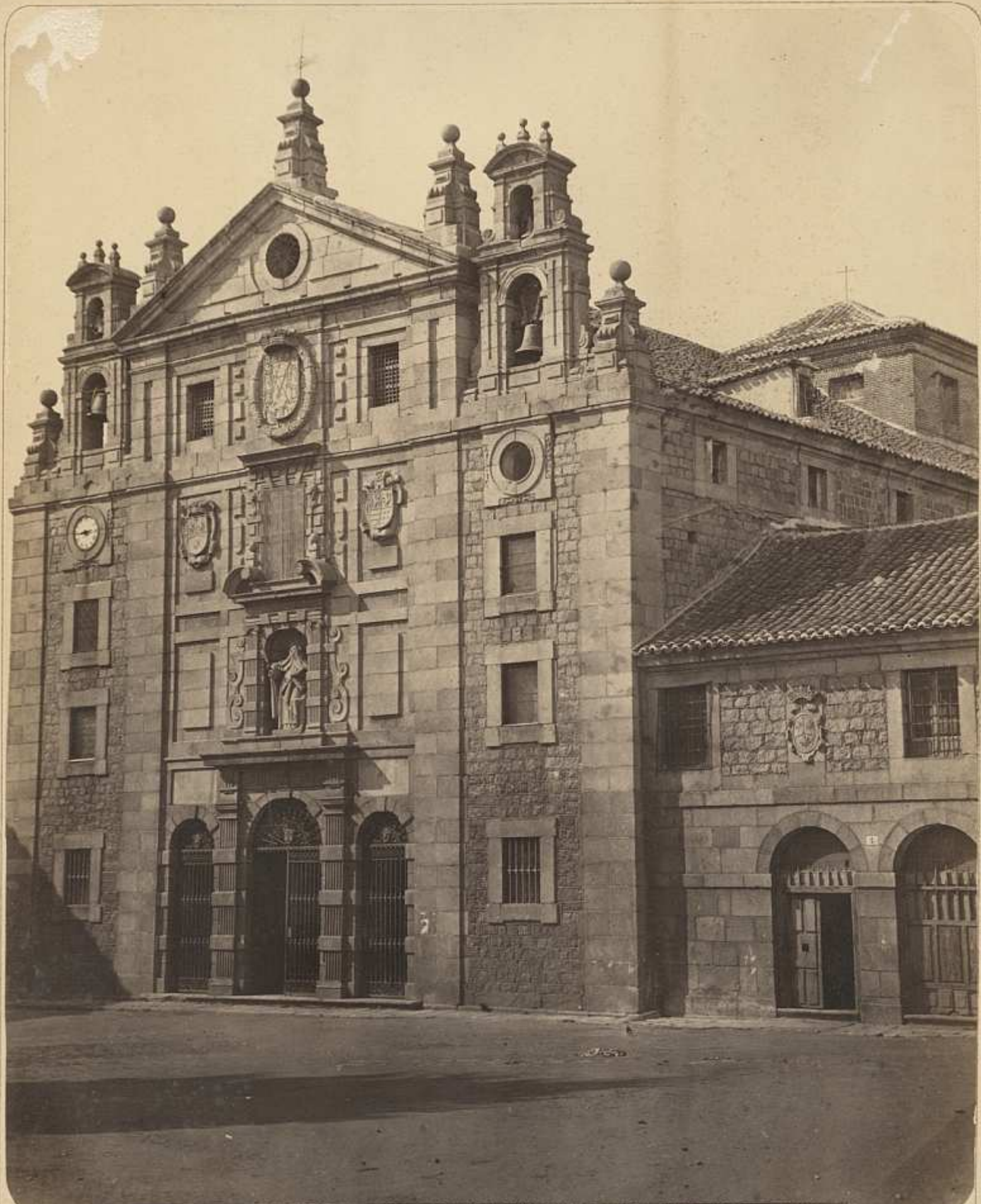
Almacil f.º—FACHADA DEL CONVENTO DE SANTA TERESA.—AVILA
