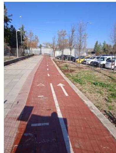
Carril bici frente al Centro de Salud, restaurado tras los daños de la riada
