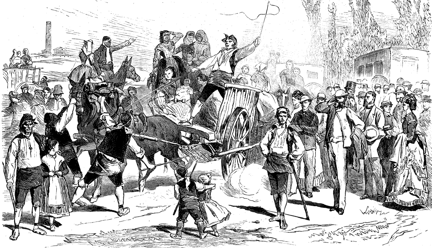
INAUGURACION DE LOS TRABAJOS DEL CANAL DE CINCO VILLAS EN ARAGON.—LLEGADA DE LOS INVITADOS.
