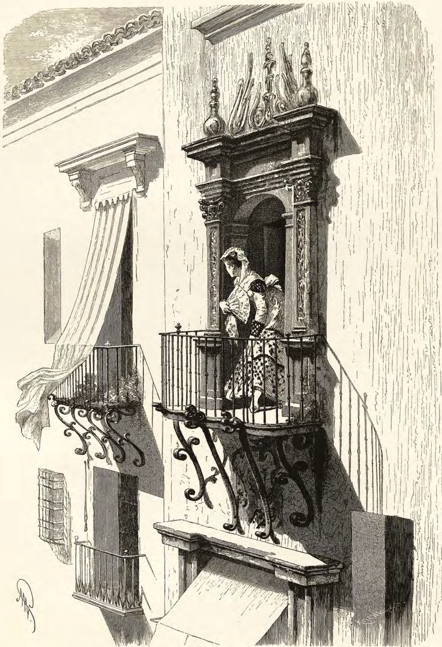
BALCON À SÉVILLE.
