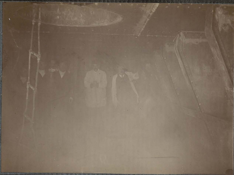
Interior de la cámara de trabajo en la fundación de una pila por aire comprimido.
