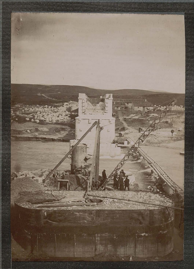
Fundación por aire comprimido de la pila estribo.
