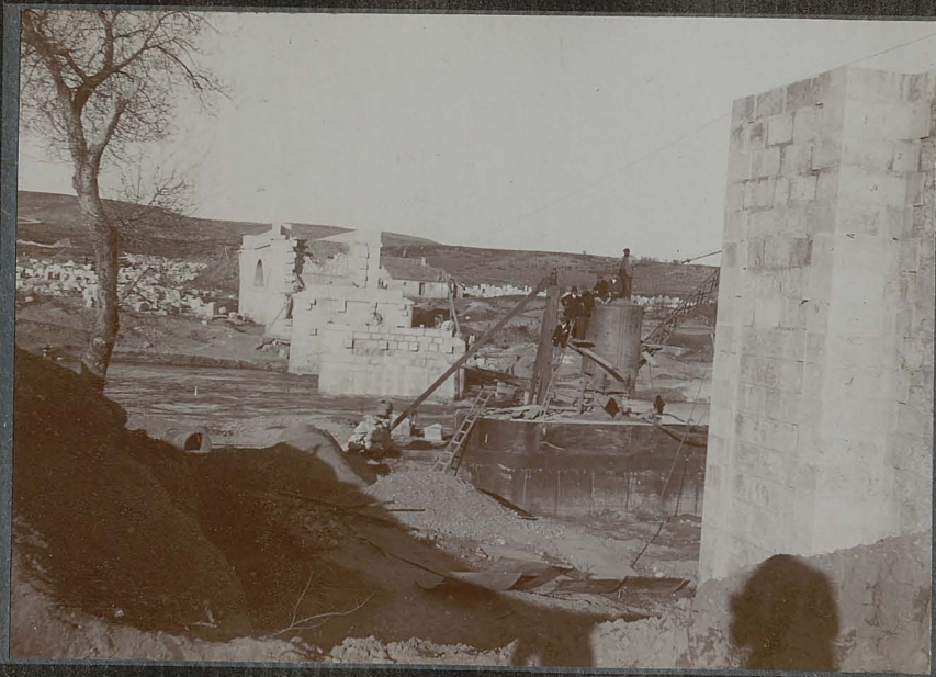
Fundación por aire comprimido de una pila.
