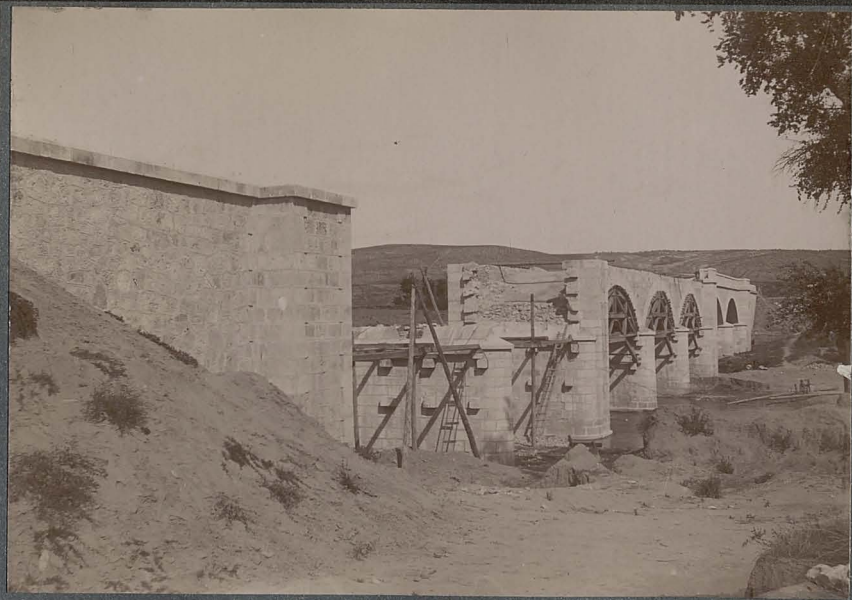
Vista general del puente antes de descimbrar los tres arcos centrales.
