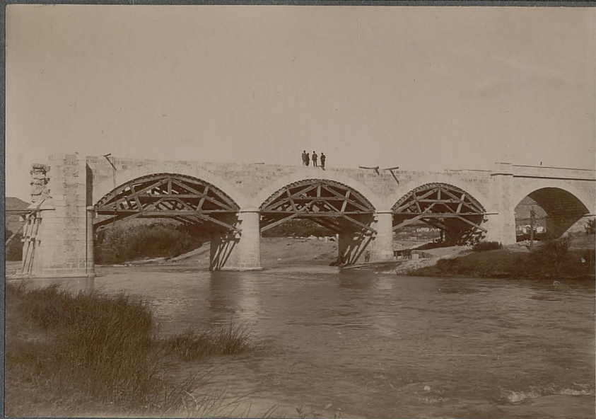
Grupo central de tres arcos antes de su desclimbamiento.
