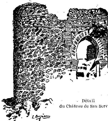
Detalle del Castillo de San Servando
