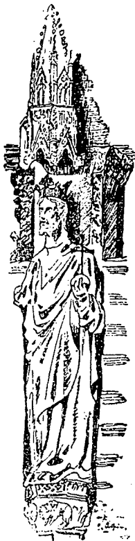
Détail de la façade extérieure du Perdón.
