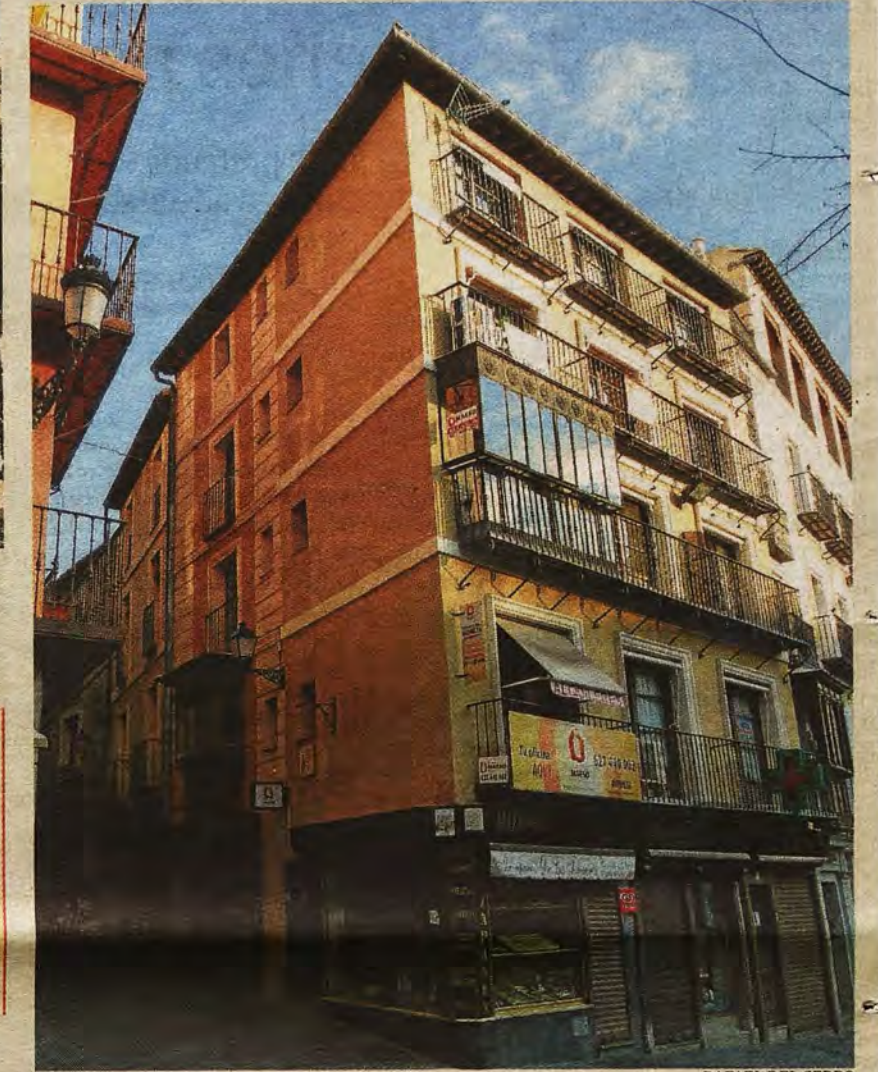
Entrada a la calle de la Sillería
