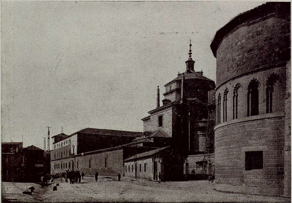
LA CARRETERA DE MADRID, EN SU ENTRADA EN TOLEDO
