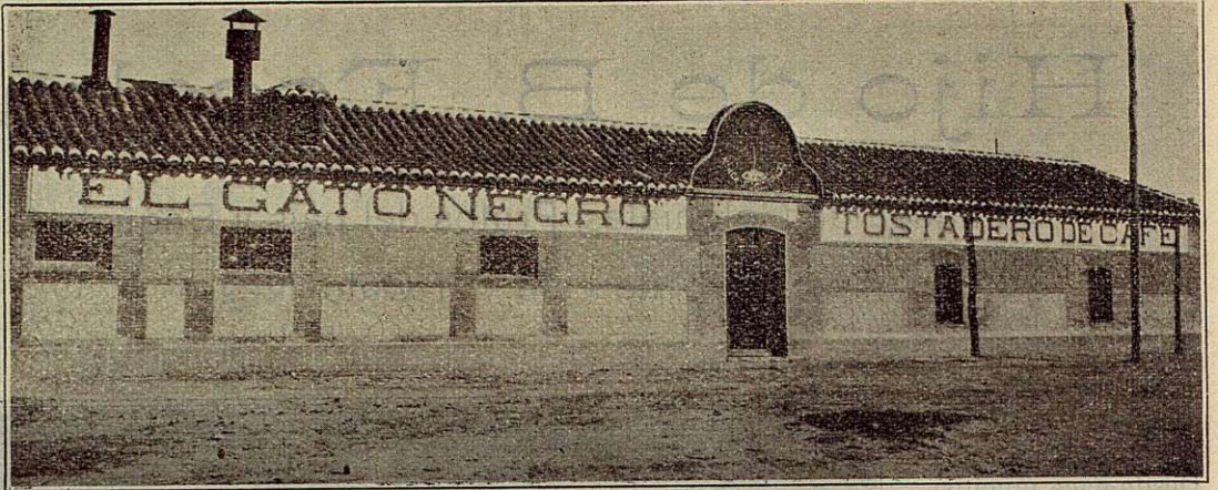
Fachada del tostadero.
