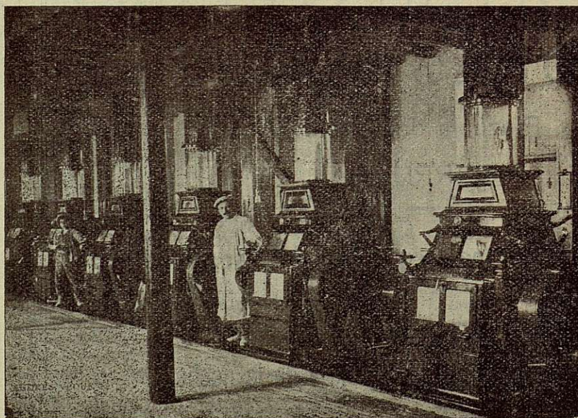
Sala de cilindros.
