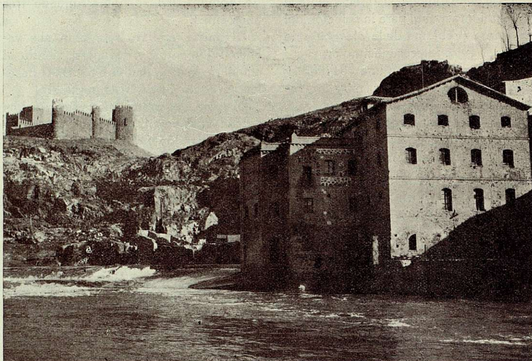
SALTO DE SAN SERVANDO
