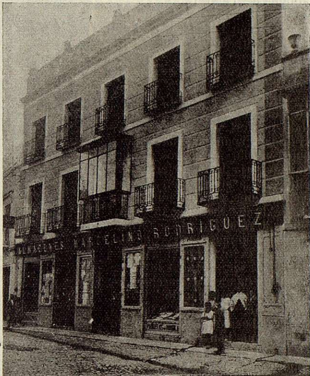
Fachada de los Almacenes.
