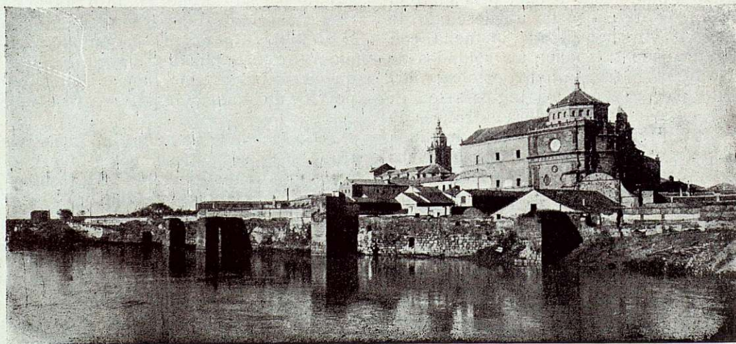
Otro aspecto de las murallas.
