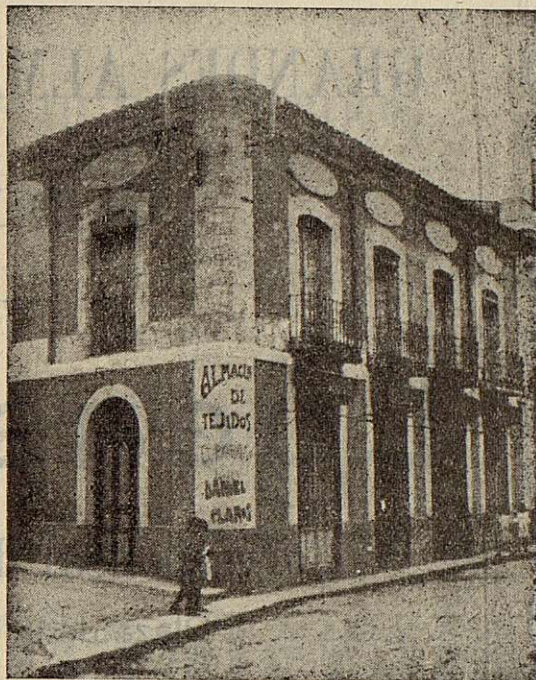
Fachada de los Almacenes.
