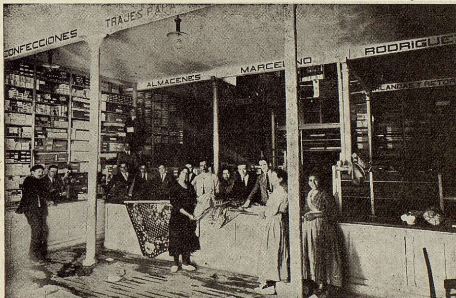
Detalle del interior de los Almacenes.
