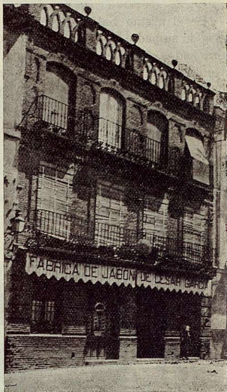
Fachada del despacho central y oficinas.
