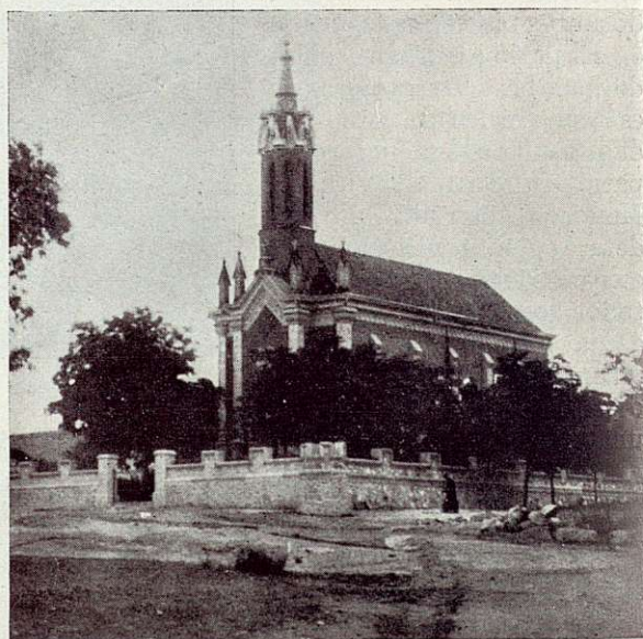
Exterior de la Capilla.
