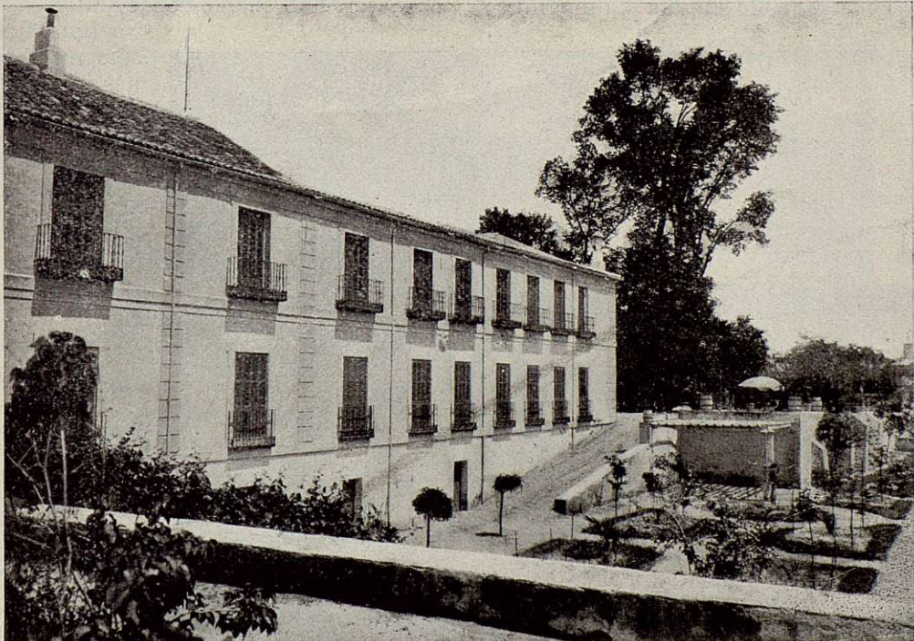
Fachada y jardín exterior.
