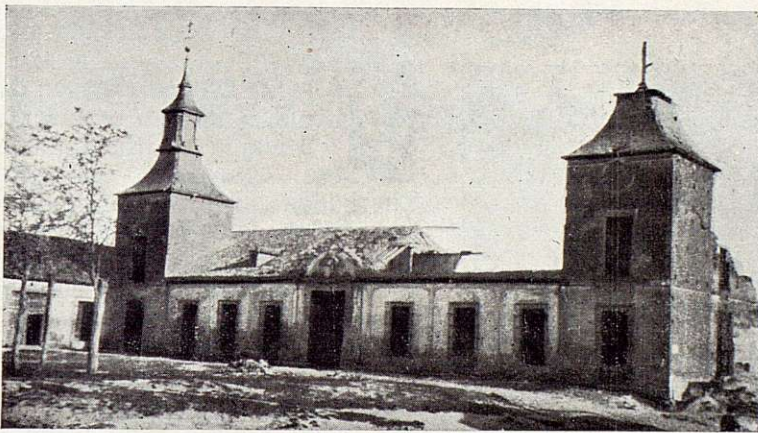
El Palacio de Ugena empezado a derruir.
