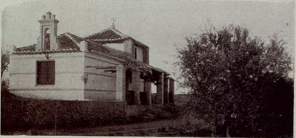
EXTERIOR DE LA CAPILLA
