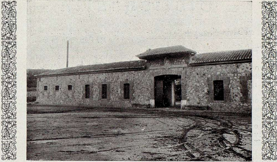
GRANJA DE SAN BERNARDO, DONDE ESTÁ INSTALADA LA ESTACIÓN SERICÍCOLA
