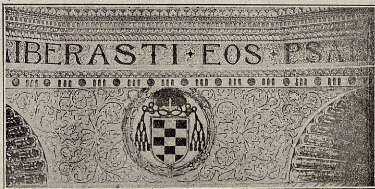
Detalle del friso descubierto de la bóveda, después de restaurado.
