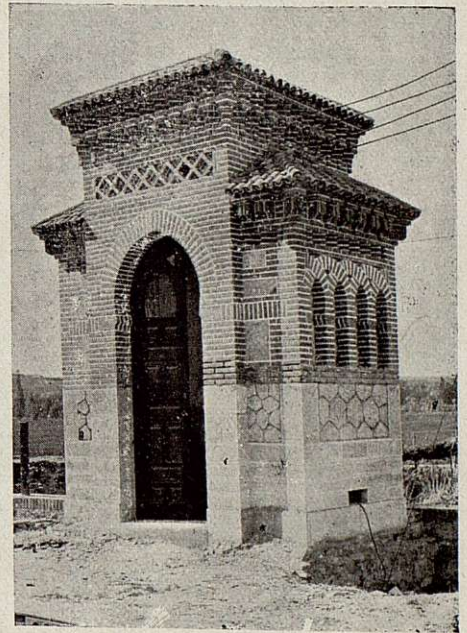
Transformador de electricidad.
