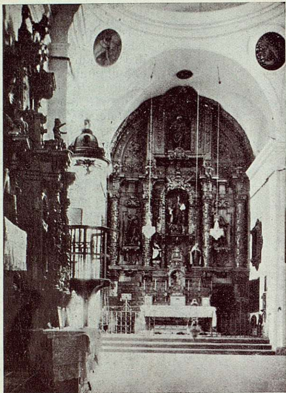
Interior de la iglesia.
