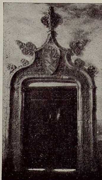
PUERTA DEL CRUCERO AL PATIO
