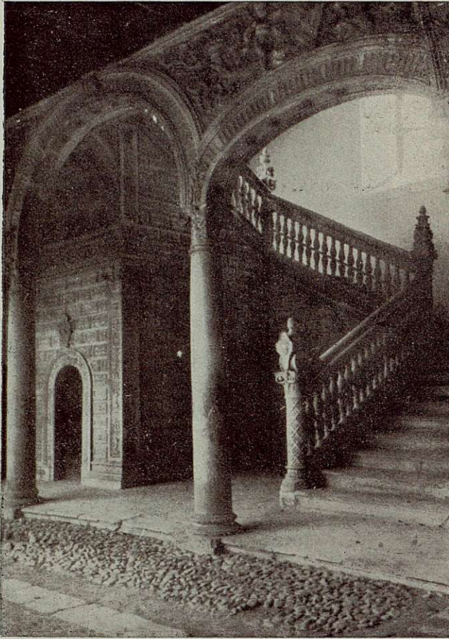
ARRANQUE DE LA ESCALERA PRINCIPAL
