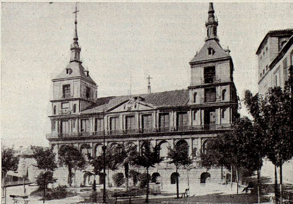
FACHADA PRINCIPAL DEL AYUNTAMIENTO
