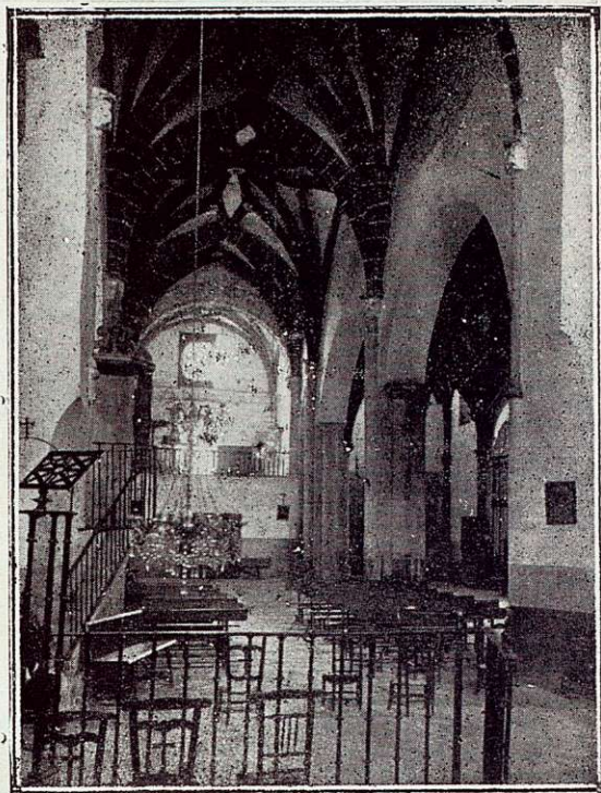
Interior de la iglesia.
