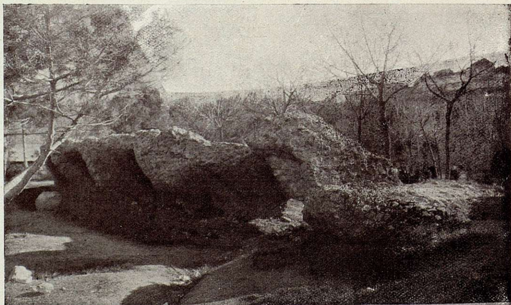
RESTO DE LAS BÓVEDAS DEL HEMICICLO, ENTERRADAS HASTA LOS ARRANQUES EN LOS ARCOS EXTERIORES
