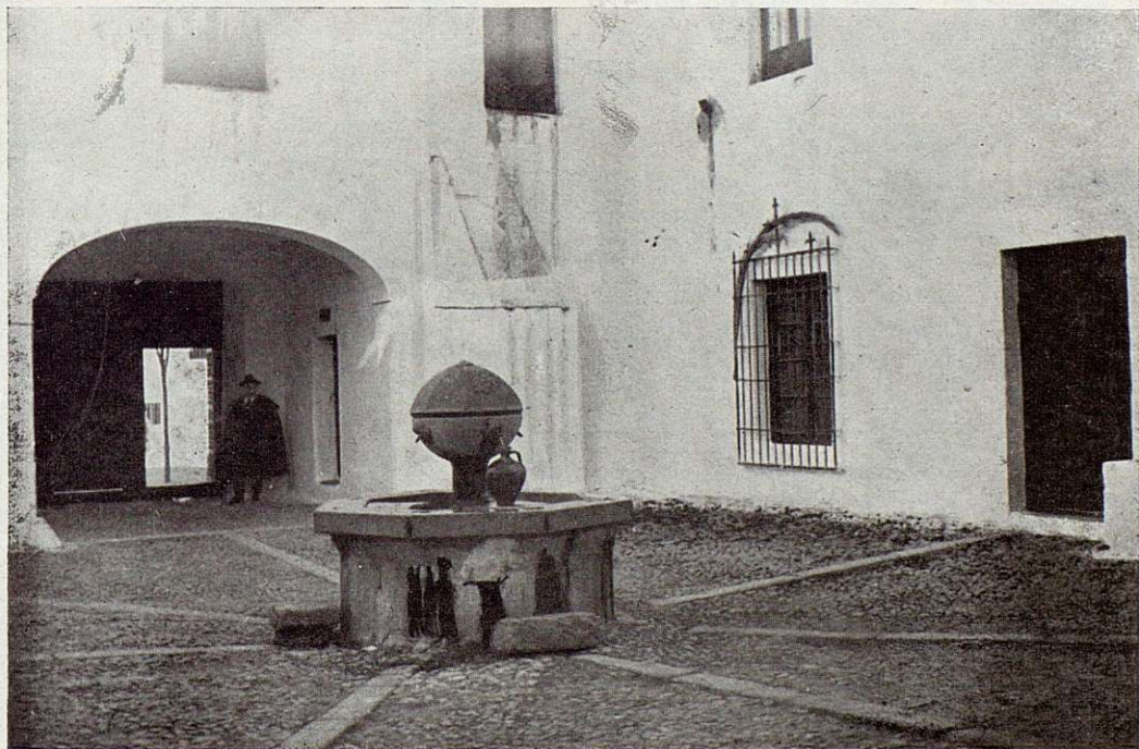
Vista general del patio.
