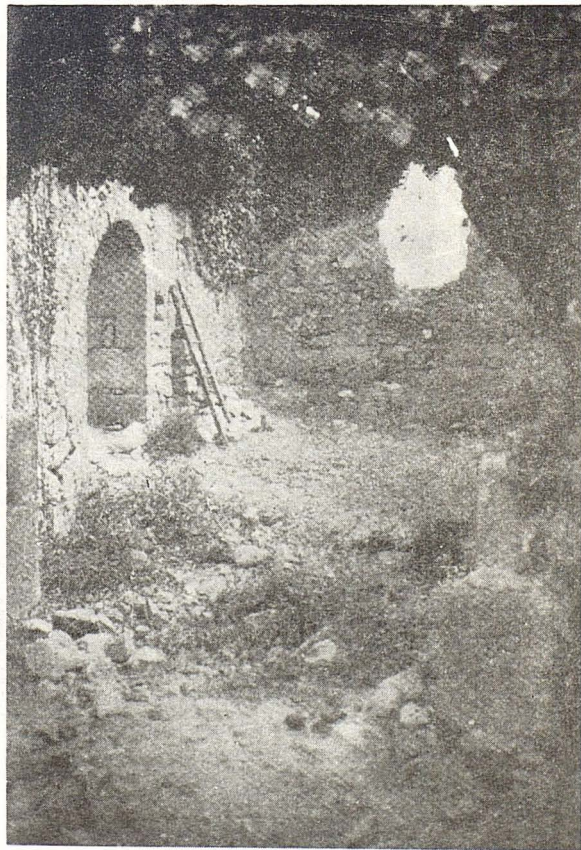
Fig. 3.— Restos del claustro bajo.
