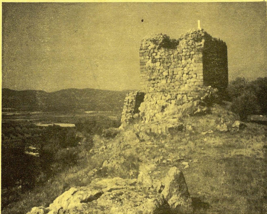
Vista general de la Torre Tolanca desde el E.
