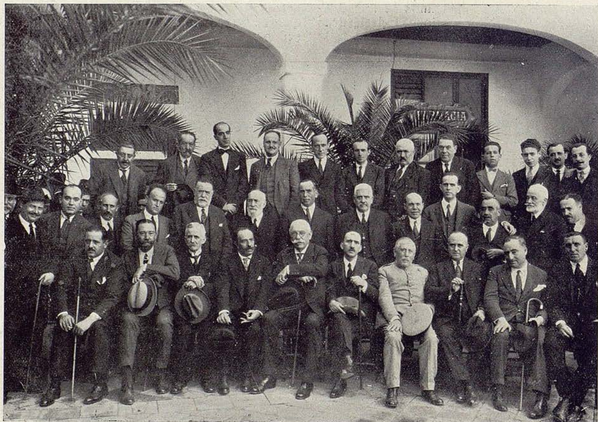
LAS AUTORIDADES E INVITADOS A LA INAUGURACIÓN DE LA NUEVA INSTALACIÓN ELECTROTÉRÁPICA
