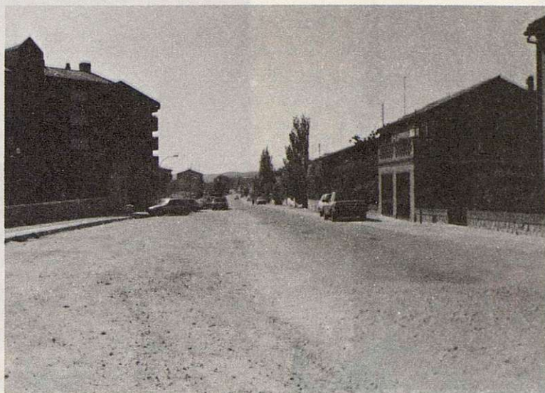
Vista del estado actual de la calle Coronel Baeza
