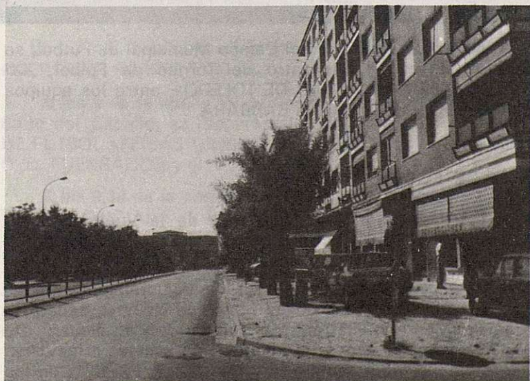
Estado actual de la margen derecha de la Avda. Barber
