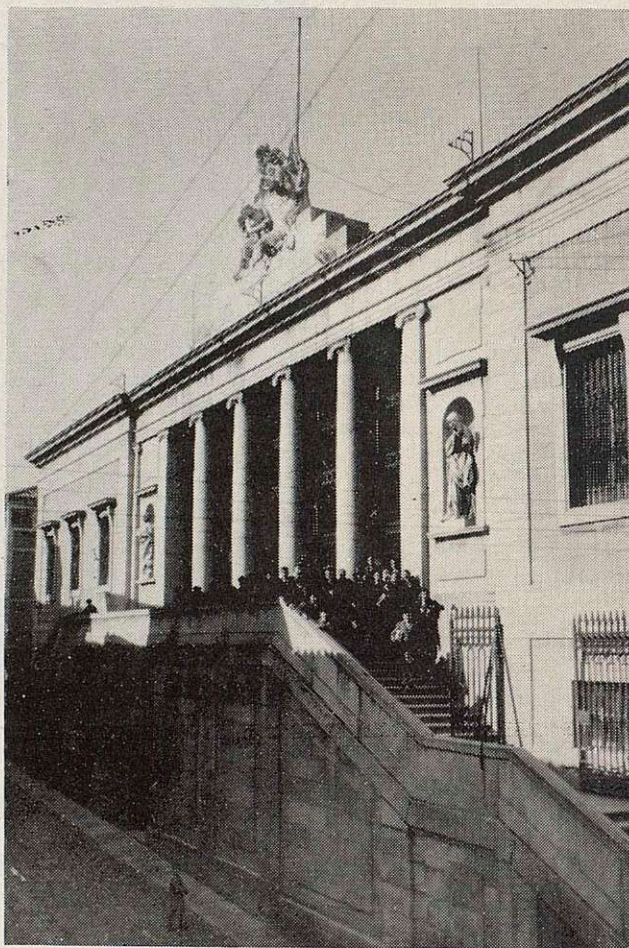
Fachada principal del que fue Instituto de Toledo
