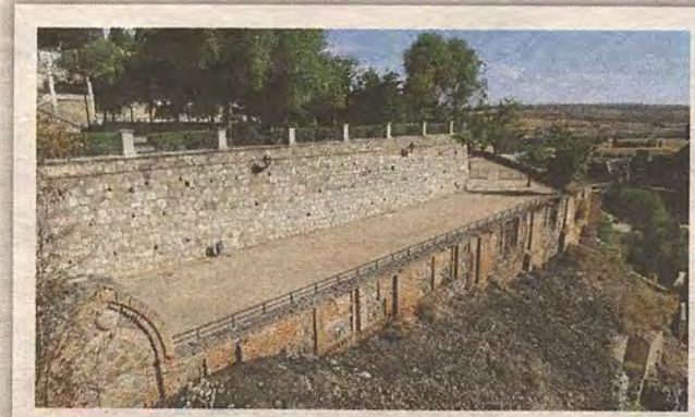
Restos del muro exterior del edificio de Santiago reutilizados en 1945 para acoger los jardines bajos del Alcázar.
