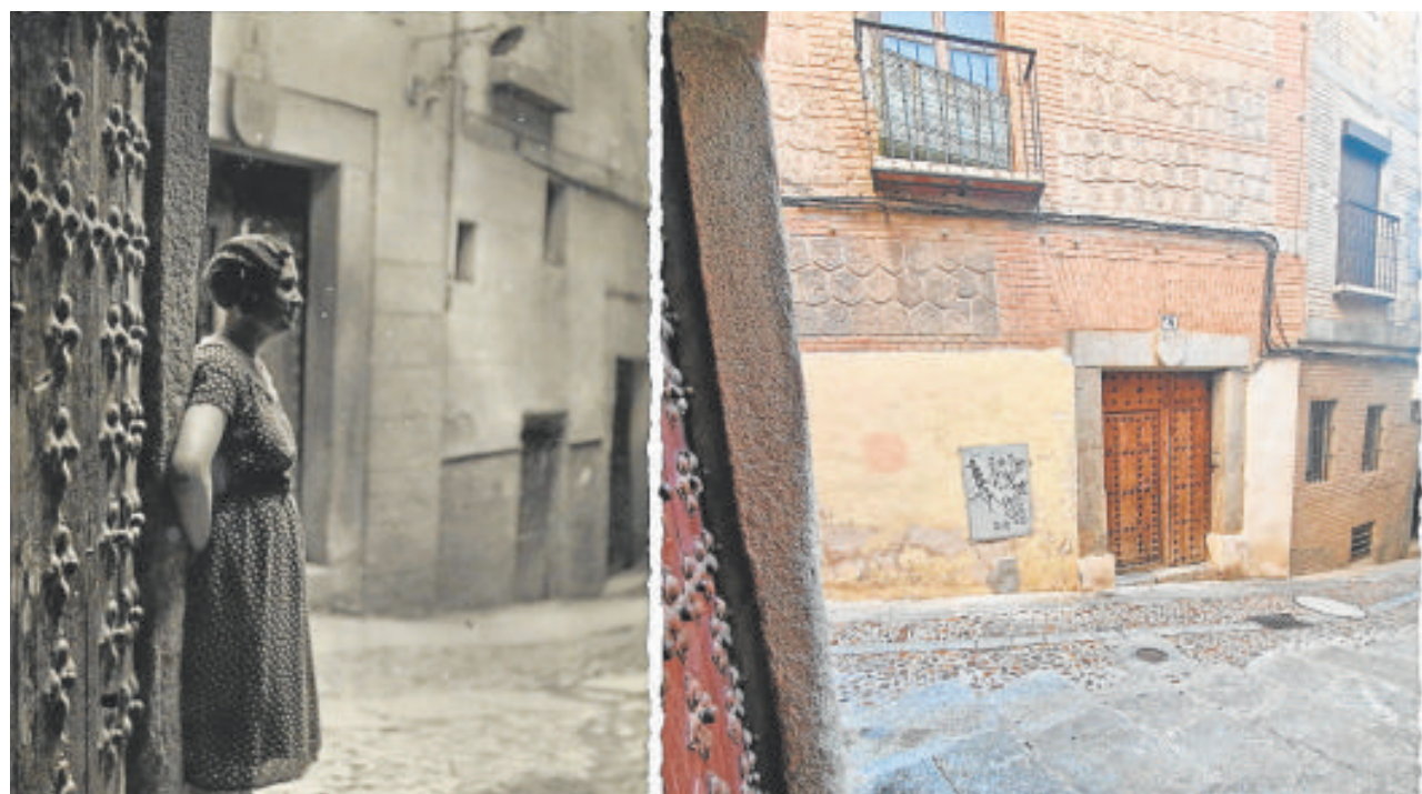
Toledana Escena de una postal de L. Roisín hacia 1933 en la calle de Juan Labrador (Archivo Municipal de Toledo). A la derecha, la misma calle fotografiada en 2023 (Agustín Puig). Aún permanecen el escudo sobre la puerta de la acera de los pares y el portón con el antiguo clavazón medieval
