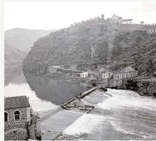
Reparación de la presa de San Martín en noviembre de 1962. Imagen captada por el fotógrafo sueco Ake Astrand. Archivo Municipal de Toledo
