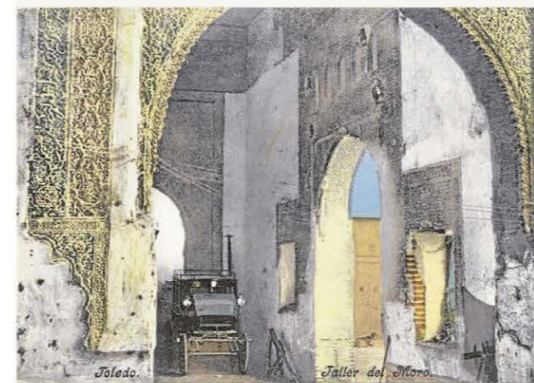
Interior del Taller del Moro, salón mudéjar del siglo XIV, donde se abrió el Jardín Eliseo en 1866. Postal editada por Purger & Co hacia 1902. Archivo Municipal de Toledo
